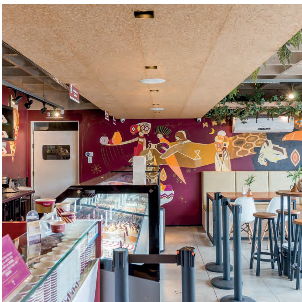
A laje nervurada da gelateria, em sua maior parte aparente, recebe iluminação cênica em trilhos e spots pontuais do CENTRO ELÉTRICO, além de um rebaixo central em gesso revestido com papel de parede em cortiça Naru da FIO TRANÇADO.
